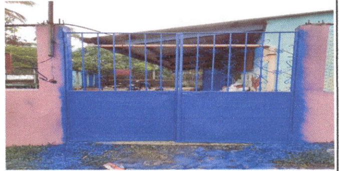
Foto 2: Sustitución de chapa.
