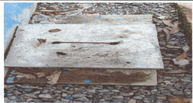
Foto 5: Reparación de drenaje y red de agua potable.
