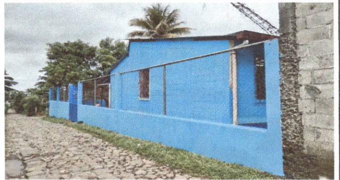
Foto 4: Pintura de muros exteriores e interiores.
