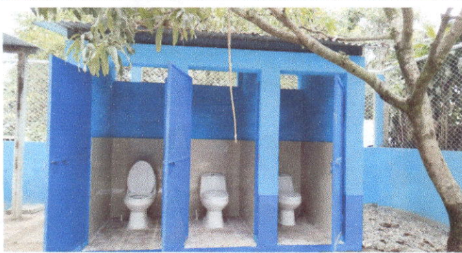
Foto 3: Piso, servicios sanitarios y accesorios.
